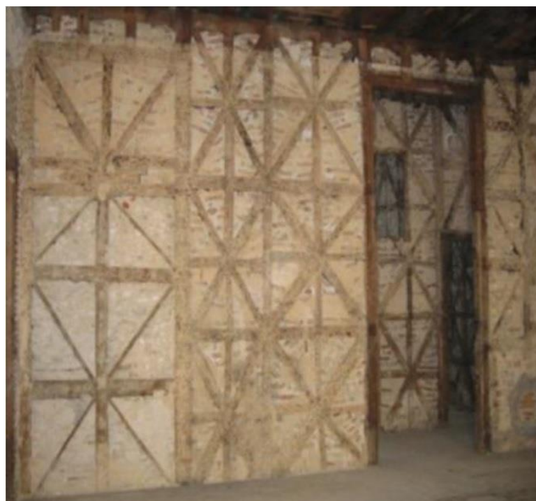
Рисунок 7 – Стена в конструктивной системе «Помбалино»
