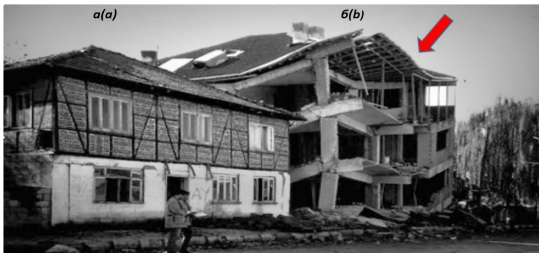
Рисунок 14 – Два здания в г. Дюздже, Турция, после землетрясения в ноябре 1999 г.: a – здание «hımış» с деревянным каркасом и каменным заполнением; б – здание с железобетонным каркасом
